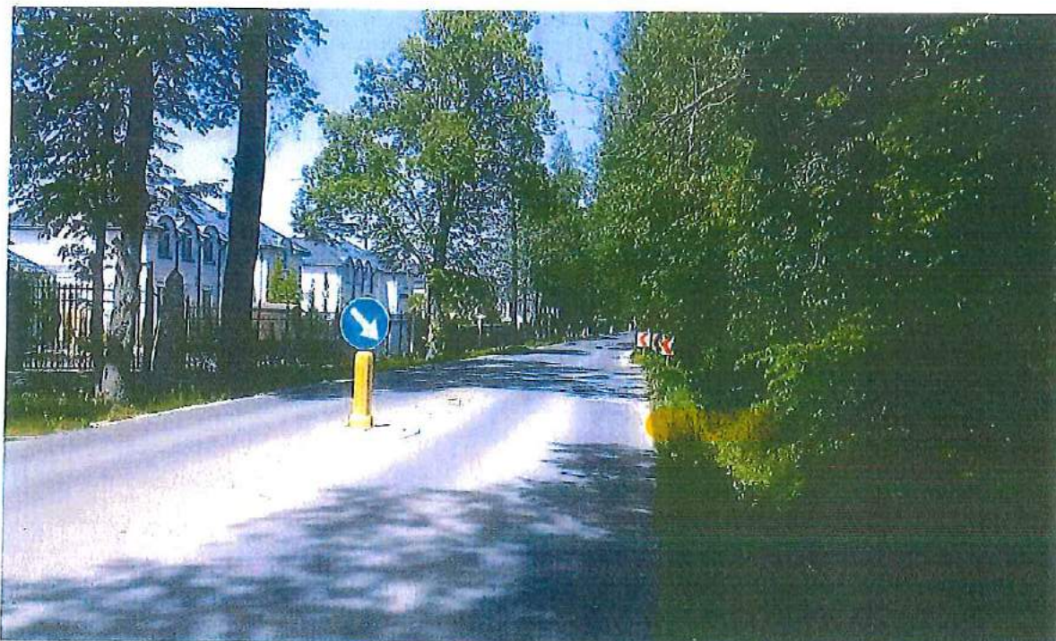
Fot.3 Lokalizacja ścieżki w pasie drogi powiatowej- przebudowa rowu przydrożnego
